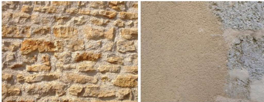
Joints beurrés à gauche et enduit à droite
